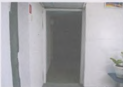
Фото № 7 – Пути движения внутри здания (коридор)
