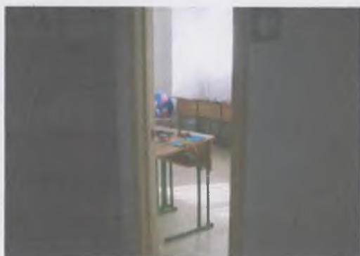
Фото № 9 – Зоны целевого назначения здания (кабинет)
