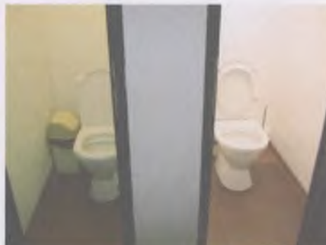
Фото № 16 – Санитарно-гигиенические помещения
