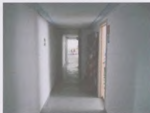
Фото № 6 – Пути движения внутри здания (коридор)
