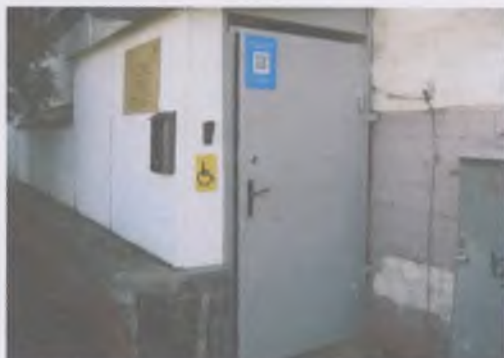
Фото № 1 – Вход в подвальное помещение, где располагается МБОУДОД «СЮТ»
