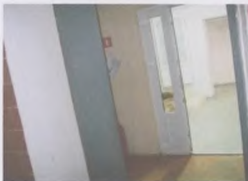
Фото № 5 – Входная дверь и тамбур
