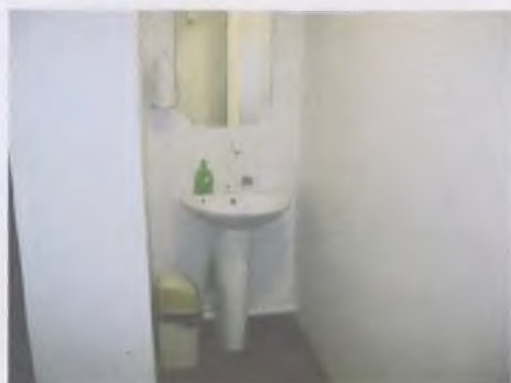
Фото № 15 – Санитарно-гигиенические помещения
